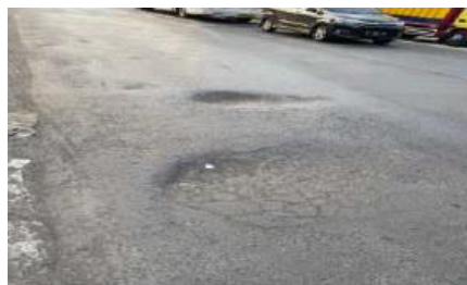
Gambar 18. Kerusakan Retak Kulit Buaya (Hasil Analisis)
